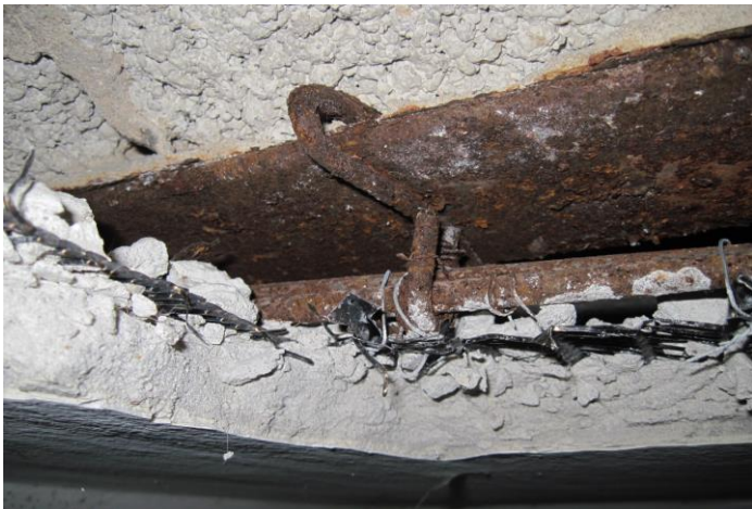
Bildbeispiele des sanierungsbedürftigen Zustandes der Ausbauten
