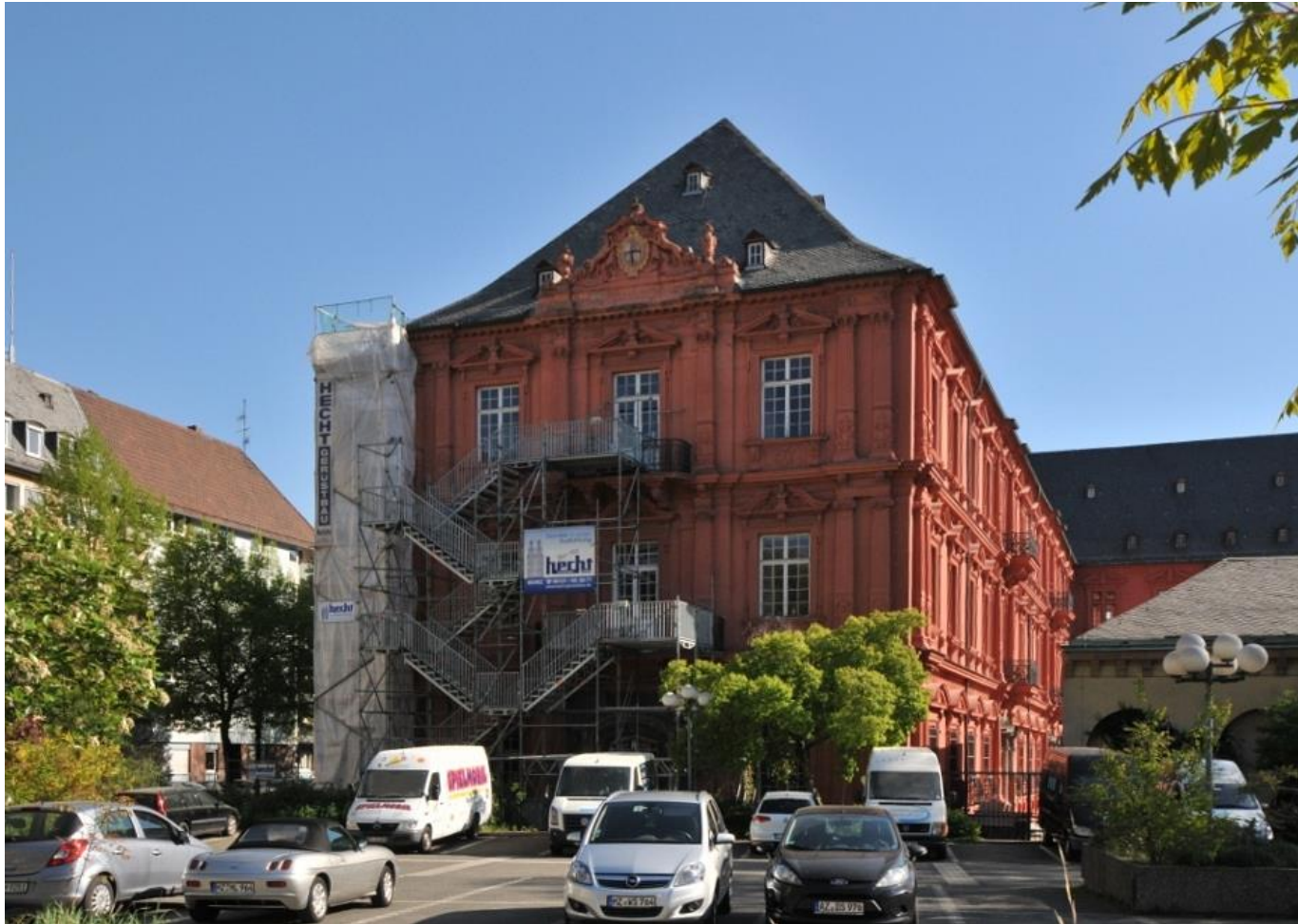
Bildbeispiele Sofortmaßnahmen zur Ertüchtigung Fluchtwege Foster-Saal, Spiegel-Saal und Empore Großer-Saal
