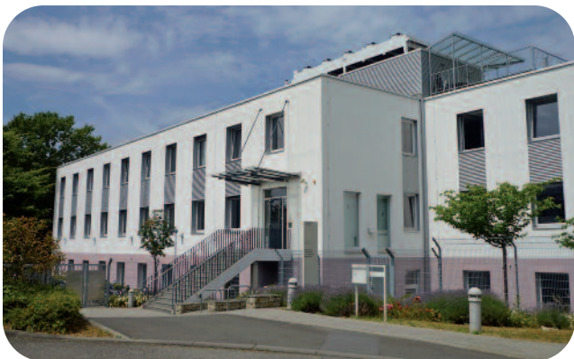
Gebäude Kommunale Datenzentrale
