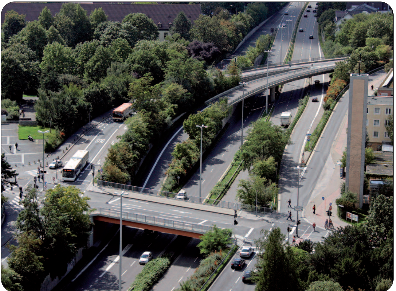
Die Straßenführung am Haupteingang der Universität vor dem Bau der Mainzelbahn
