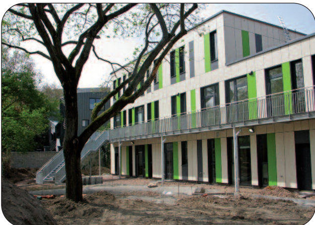
Neubau Kita Gabelsbergerstraße in der Neustadt
