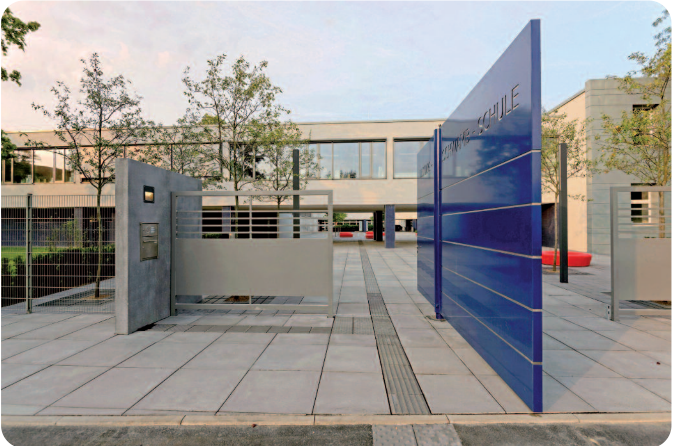
Toranlagen im Haupteingangsbereich zu der Ludwig-Schwamb-Schule an der Schillstraße
